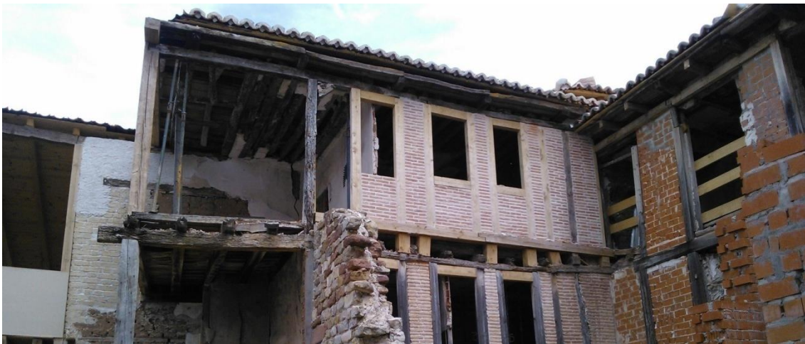
Gráfico 29. Edificio en obras en la travesaía baja, con entramado de madera y plementería de fábrica
