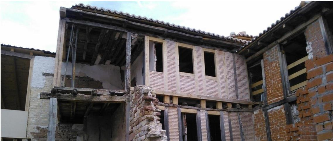
*Gráfico 81. Edificio en obras en la travesaía baja, con entramado de madera y plementería de fábrica*
